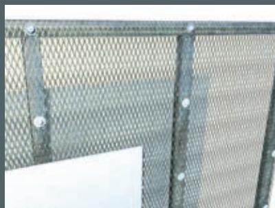
**Fixation :** Fixez au métal, tous les 450mm au maximum avec des vis taraudeuses plaquées en zinc n° 6 ou 8 x 30 avec des rondelles galvanisées de 25mm dia. x 1,5mm.
